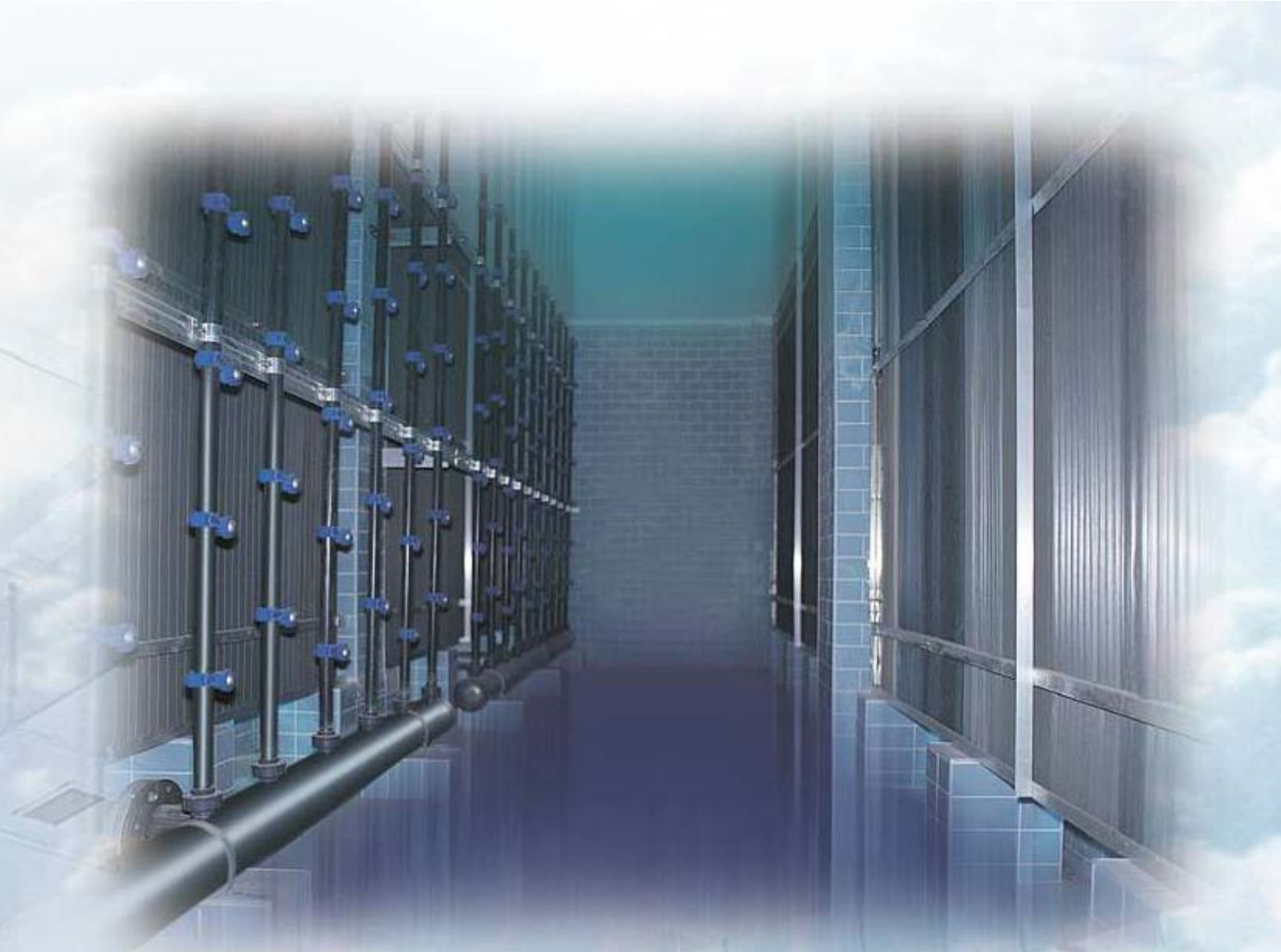
İnşai tip nemlendirme hücresi Masonry type airwasher
